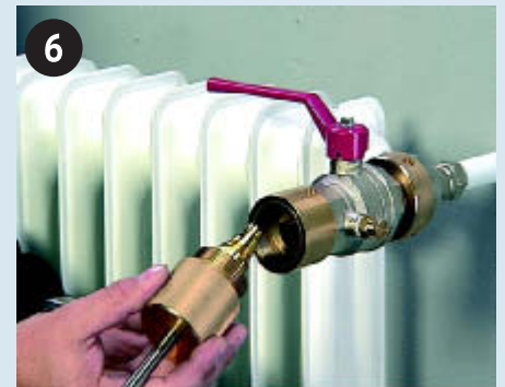
■ Der neue Ventileinsatz kann jetzt mit der Spindel in das alte Ventil eingedreht werden. Nach der Demontage der Schleuse wird mit einem 21er-Ring- schlüssel der neue Ventileinsatz mit mindestens 30 Nm angezogen.
