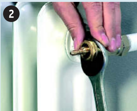
■ Zum Halten der alten Bodenschraube wird ein Greifer in den Ventileinsatz eingesetzt. Dieser stellt die Verbindung zwischen Schleusen- spindel und Bodenschraube her. Bei RAVL-Ventilen besteht zusätzlich die Möglichkeit, auch bei nicht- demontierbarer Stopfbuchse den Schleusenvorgang durchzuführen. Mit dem montierten Greifer wird die Bodenschraube gelöst.
