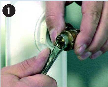
■ Bei den Ventilen RA und RAVL muss vor der Demontage die Stopfbuchse entfernt werden. Dies ist bei den RAV-Ventilen nicht notwendig. Die Demontage kann bei Danfoss-Ventilen unter Anlagen- druck erfolgen.
